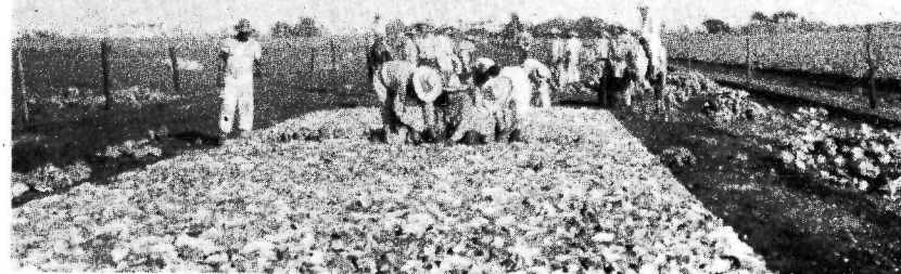
El enrajonado de la carretera de Alacranes a Conchita, listo para recibir la presión del cilindro de 15 toneladas.
